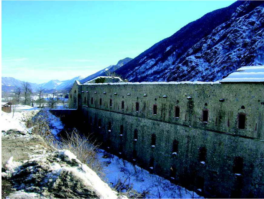
Il Forte Albertino a Vinadio, la manica
