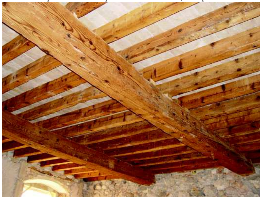
Solaio piano con struttura in legno
