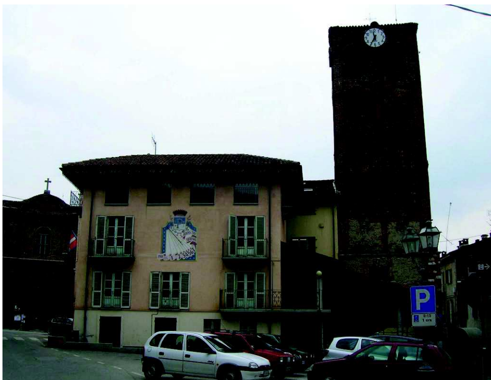
Municipio di Piasco e torre civica
